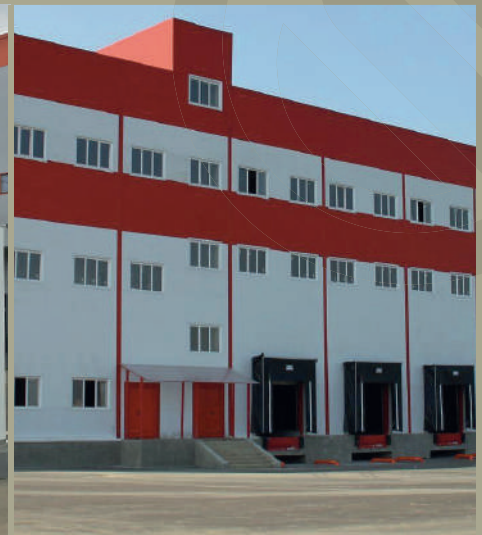
Распределительный центр «Магнит» - Стерлитамак
